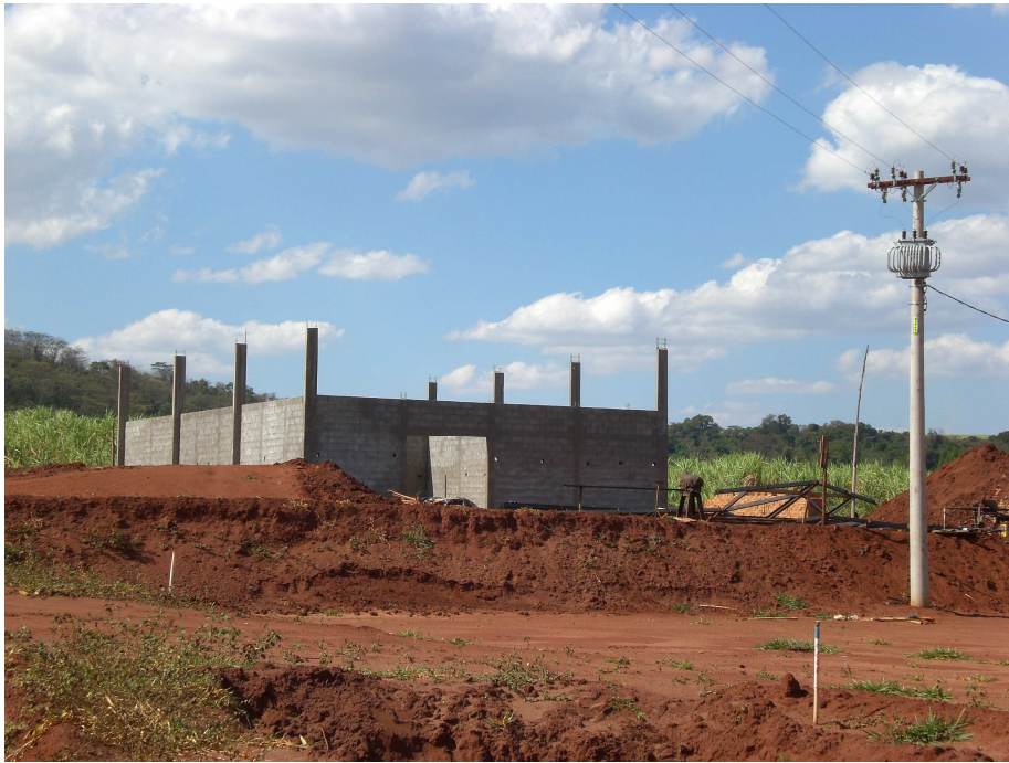
Farinheira no Bela Vista no início da construção
