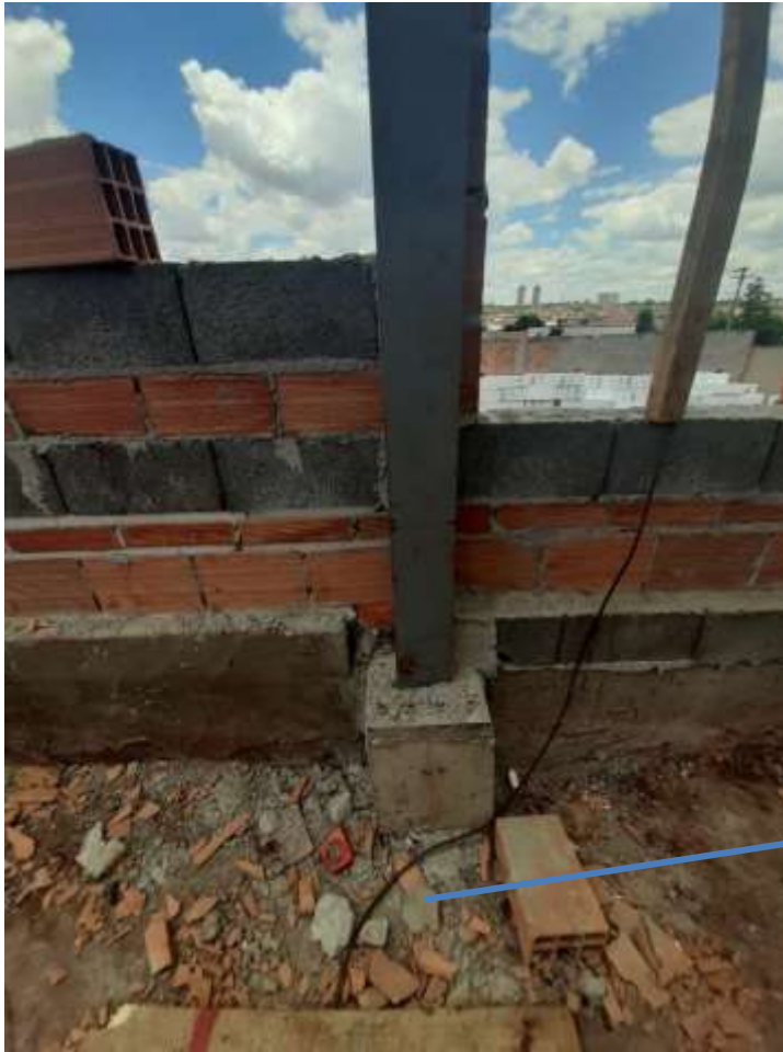
Figura 8-Foto de obra em execução
