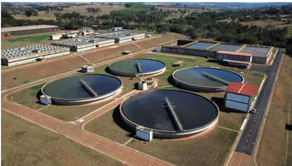
Figura 18 – Estação de Tratamento de Esgoto Rio Preto
