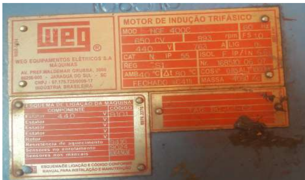
Figura 22: Foto da placa de identificação dos motores da EEEB 01
