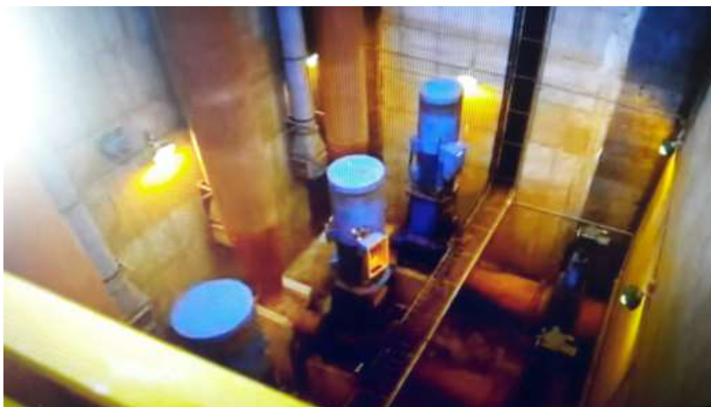
Figura 19: Casa das bombas da ETE Rio Preto (estação elevatória)
