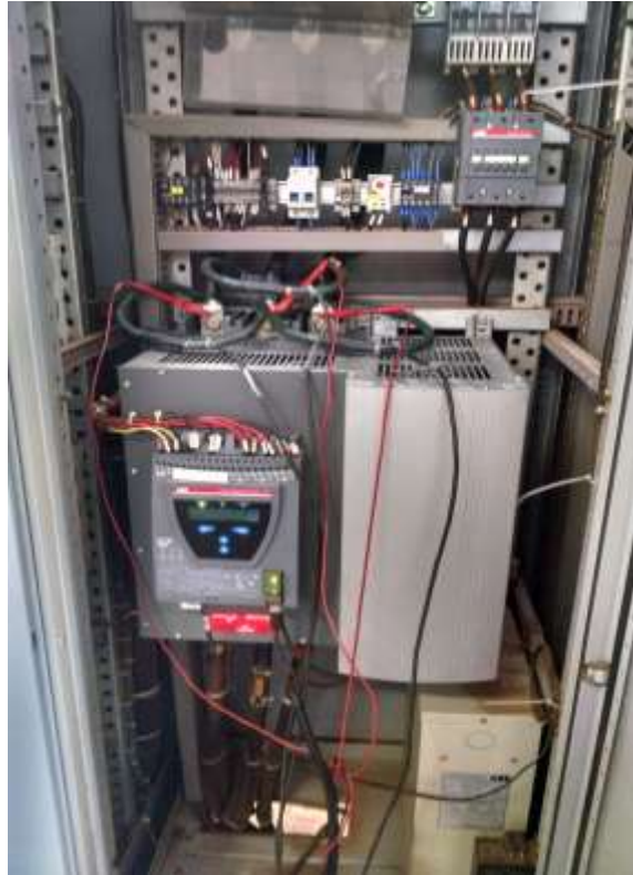
Figura 23: Fotografia das instalações dos registradores do soprador 002
