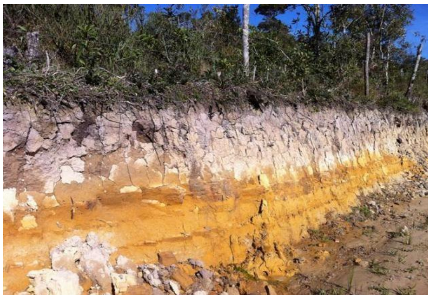
Figura 10: Barranco e corte de estrada
